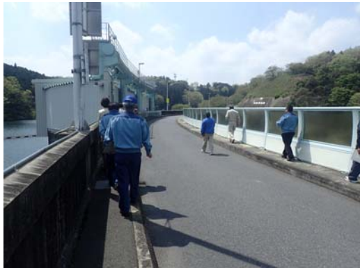
ダム天端道路点検状況
