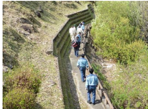
貯水池周辺親水エリア点検状況
